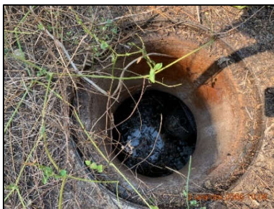
บ่อพักน้ำหลังผ่านระบบบำบัดน้ำเสียอาคารที่พักผู้โดยสาร
