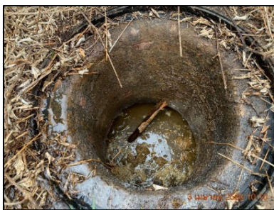
บ่อพักน้ำก่อนผ่านระบบบำบัดน้ำเสียอาคารที่พักผู้โดยสาร
