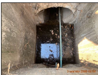
บ่อพักน้ำสุดท้าย ก่อนระบายลงรางระบายน้ำ
